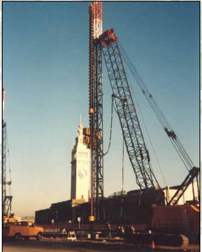
*навесной вращатель модели 75 предназначен для лидерного бурения; установлен на боковой части направляющей, на передней части которой установлен вибропогружатель King Kong*
