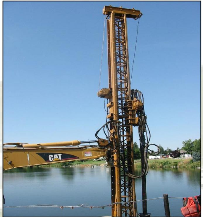
*мачта с выдвижным речным механизмом и навесным вращателем модели 20, вращающим пневмоударник*
