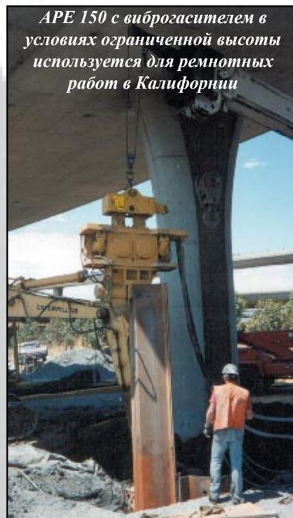
*АРЕ 150 с виброгасителем в условиях ограниченной высоты используется для ремонтных работ в Калифорнии*
