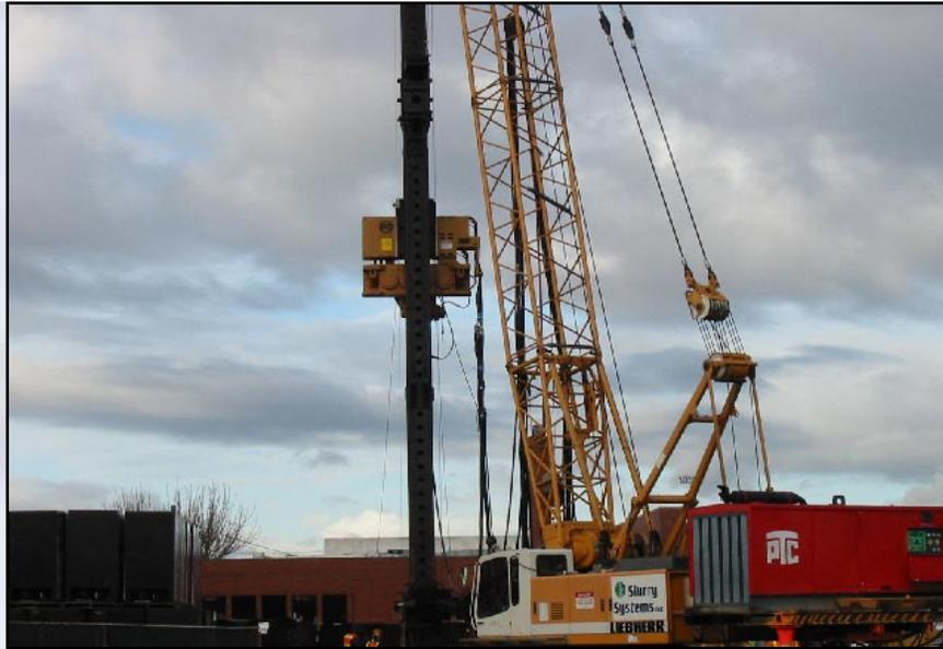
*Slurry Systems используют APE модель 200 для погружения свай, с которым не справился их молот*
