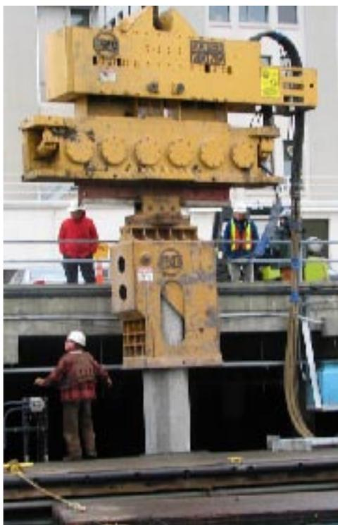
вибропогружатель модель 600 с балкой трубного наголовника и переходником, поворотной на 90 градусов плитой и наголовником для 30-дюймовых ж/б свай погружает 8-гранные 24-дюймовые сваи длиной 30 м
