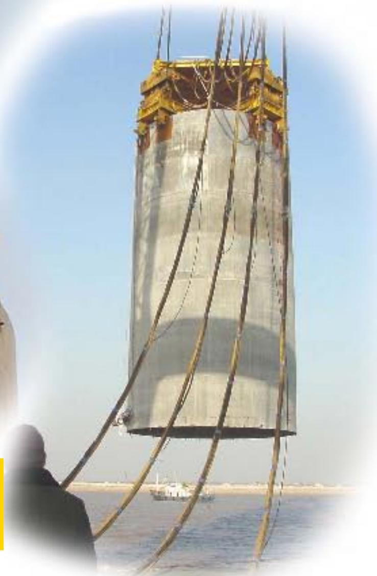
вибропогружателя: 91 т • возмущающая сила: 1440 т
