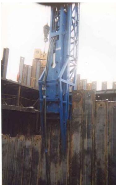
Оффшорные направляющие ARE предназначены для того, чтобы обеспечить полный контроль при забивке и вертикальных, и наклонных свай. Имеются наголовники и для труб, и для бетонных свай.
